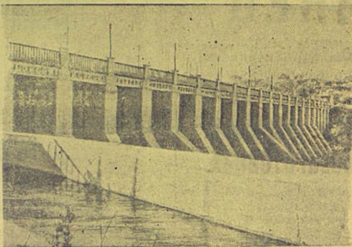
Киевская область. Восстановлена Корсунь - Шевченковская гидроэлектростанция, разрушенная во время войны немецко-фашистскими оккупантами.
