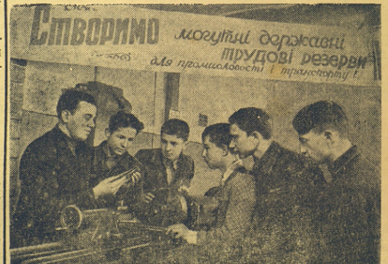
Мастер фрезерного дела ремесленного училища № 8 в г. Киеве Б.М. Дробот объясняет ученикам назначение головки вертикального фрезерного станка. Фото А. Грибовского. Фото ТАСС.
