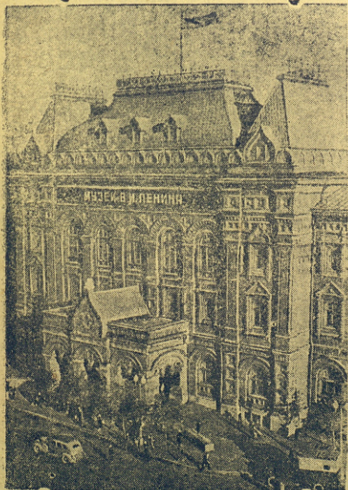
На снимке: Здание Центрального музея В. И. Ленина в Москве.
