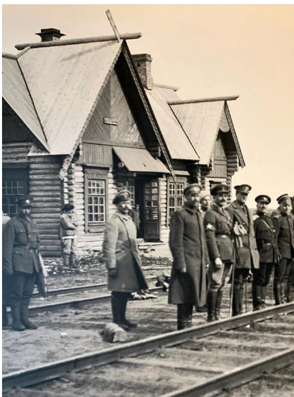
Вокзал в избяном стиле станции Шуерецкое. Фото 1918 г.
