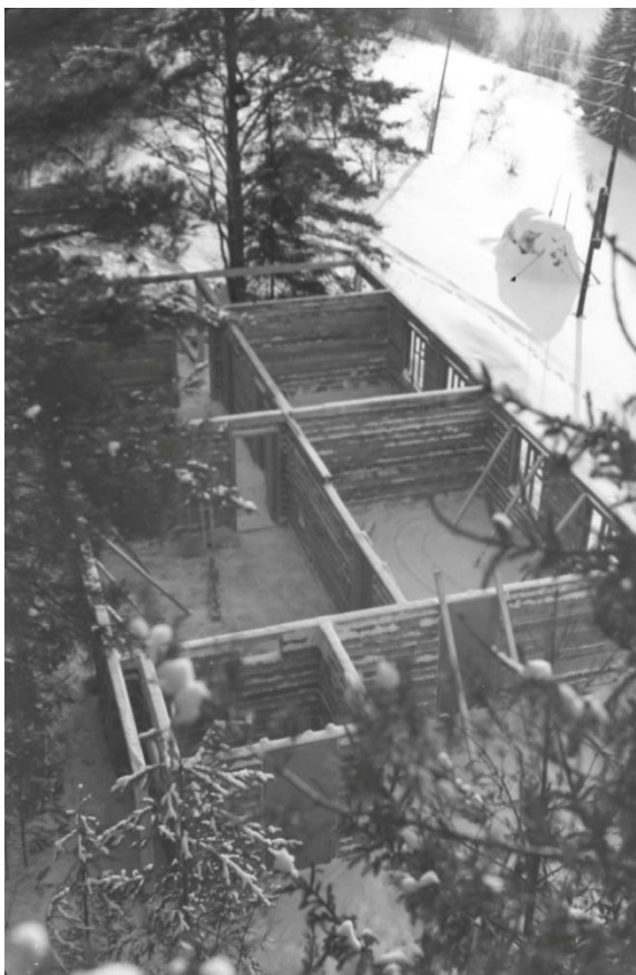
Начало строительства научной лаборатории, 1980 г.
