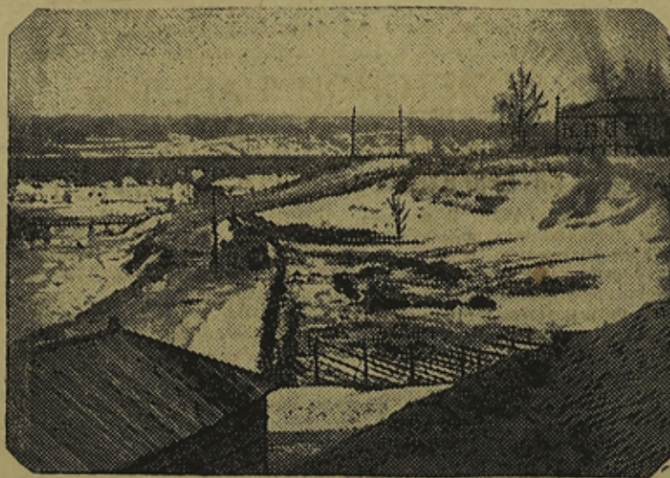
В ближайшие дни начнутся работы второй очереди по устройству парка культуры и отдыха у Онегзавода. НА СНИМКЕ: место на берегу р. Лососинки, где будут производиться работы. Фото Я. РОСКИНА.
