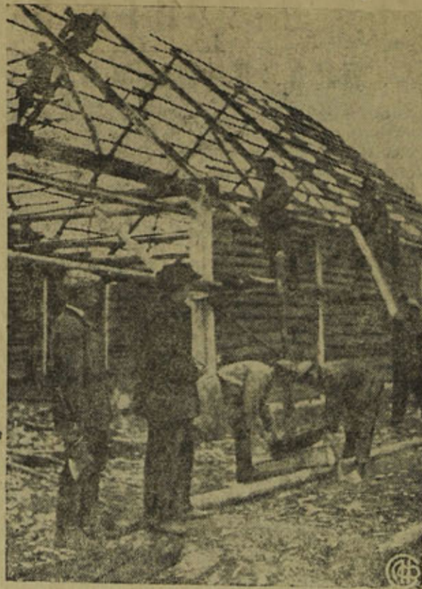
Колхоз "Голубье" Псковского района Ленинградской области готовится к уборочной. Заканчивается стройка молотильного пункта, проверяются молотилы и т.д. На снимке: бригада тов. НИКОНОВА В. И. строит молотильный пункт. (Союзфото)
