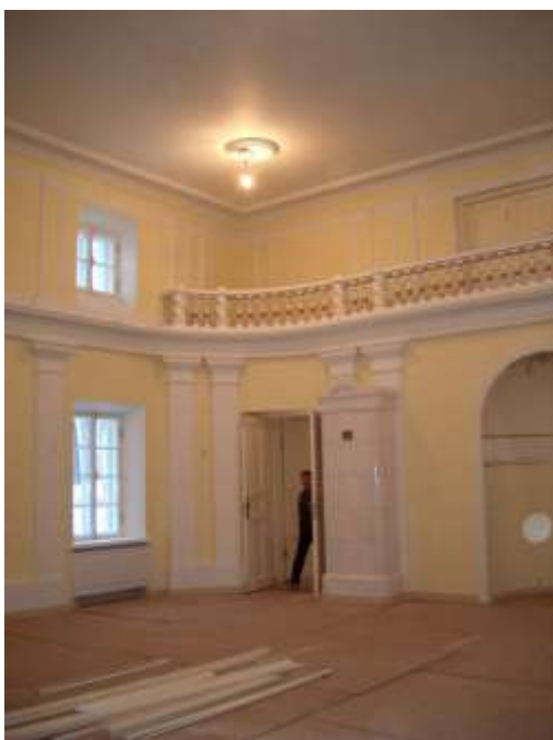
Большой зал губернаторского дома в 2002 году, во время реставрационных работ
