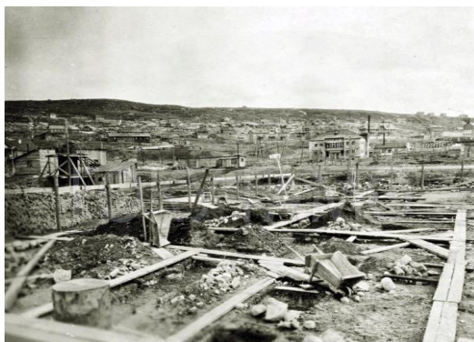
Разрушенный поселок железнодорожников.
