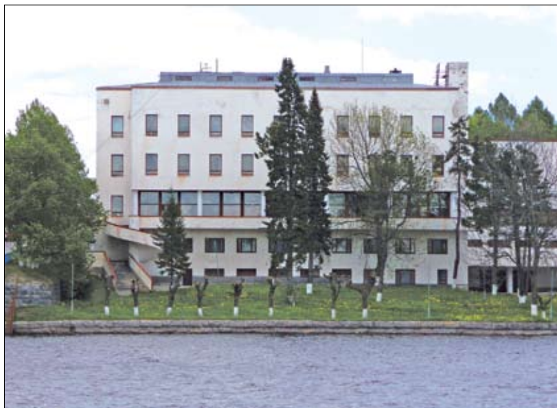
Современный вид гостиницы «Сеурахуоне». Фото 2009
