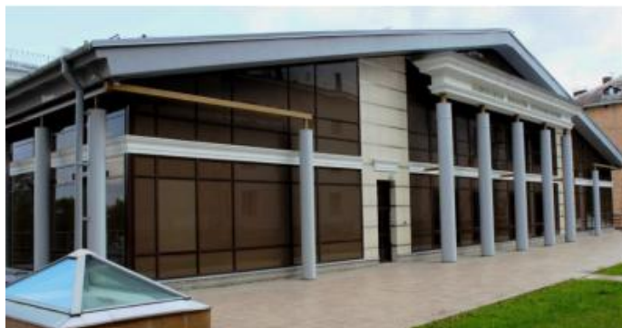
Пристройка к зданию Национальной библиотеки Республики Карелия (автор проекта – архитектор А.П. Гречкин, 2014 г.).
